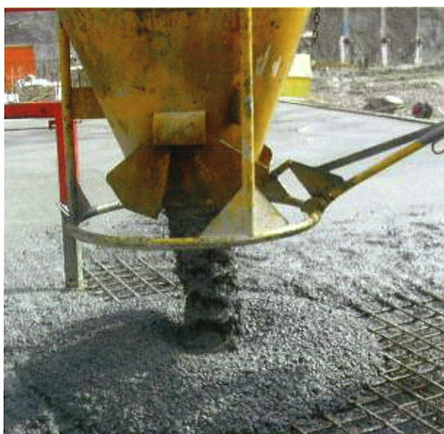
Mise en place d'un Ecobéton® de structure
