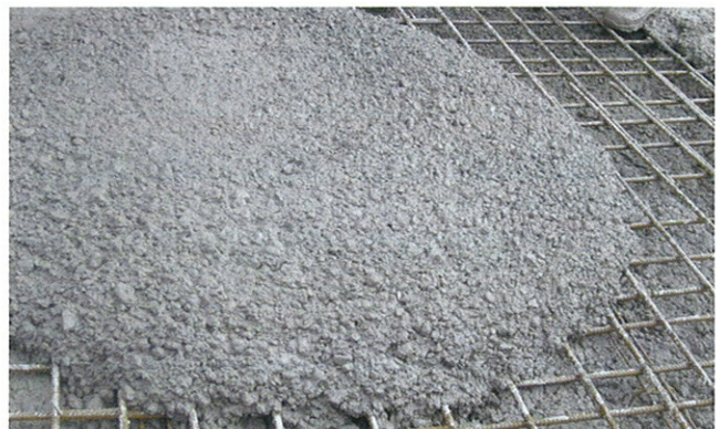
Mise en place d'un Ecobéton® de structure
