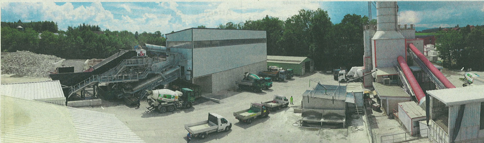
La Gravière de la Claie-aux-Moines produit du béton recyclé, créé en réutilisant des matériaux issus de la démolition.
